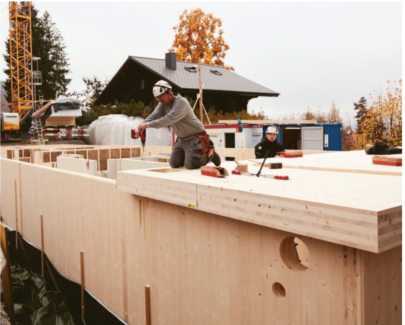
Die Brettsperrholzplatte über dem Untergeschoss dient als Lastverteilplatte für das Erdgeschoss.
