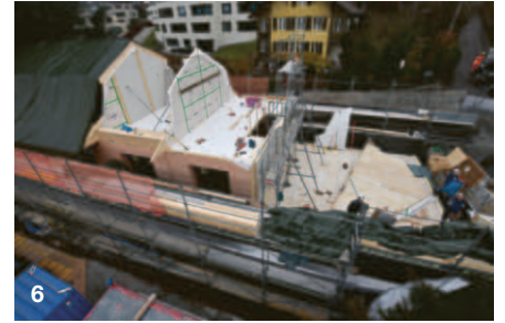
Darauf wird das Holzgebäude vom Holzbaunternehmer aufgerichtet.
