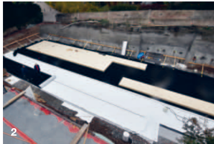
2 Ein Schutzvlies schützt die Abdichtung und das integrierte vollflächige Feuchtemonitoring.
