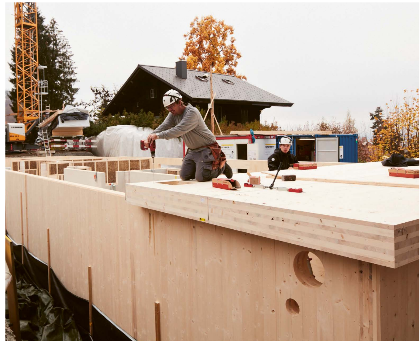
4 Die Wände im Untergeschoss sind aus Brettsperrholzplatten.
