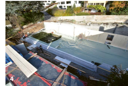
4 Die Wände im Untergeschoss sind aus Brettsperrholzplatten.
