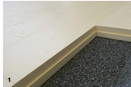
1 Auf einer Splitt-Schicht werden 160 Millimeter dicke Dämmplatten verlegt.
