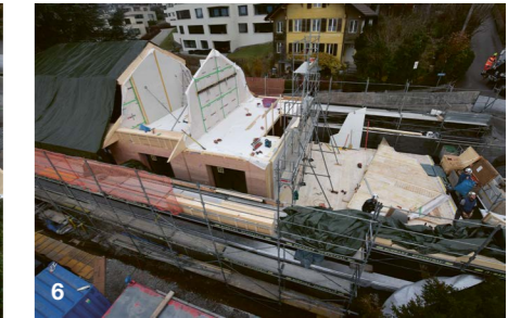
6 Darauf wird der Holzbau wie gewohnt aufgerichtet.
